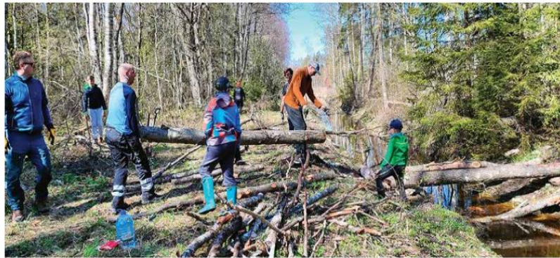
Rohesildade ehitusel kasutati sillapalkideks tormis langenud puid. / Fotod: Vääna kogukond
